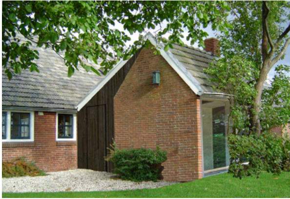
entree in het vlak van de kopgevel
