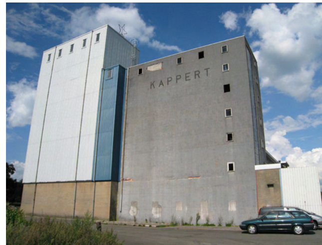
stalen en betonnen silogebouw
