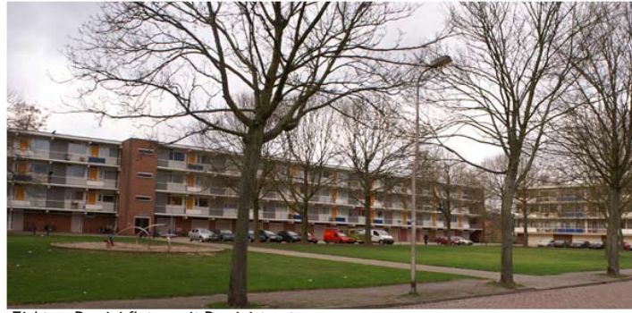
Zicht op Rossini flat vanuit Rossinistraat
