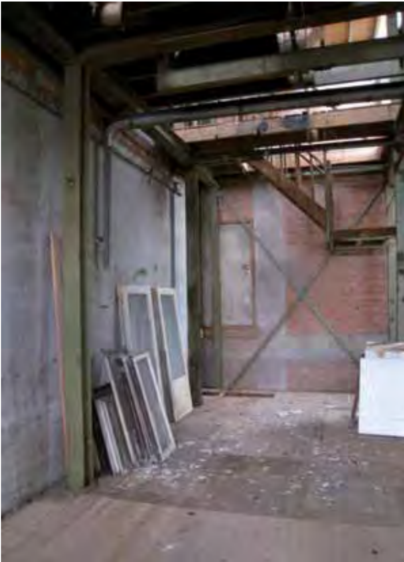
Silo Hancate Hellendoorn, bestaande situatie, interieur
