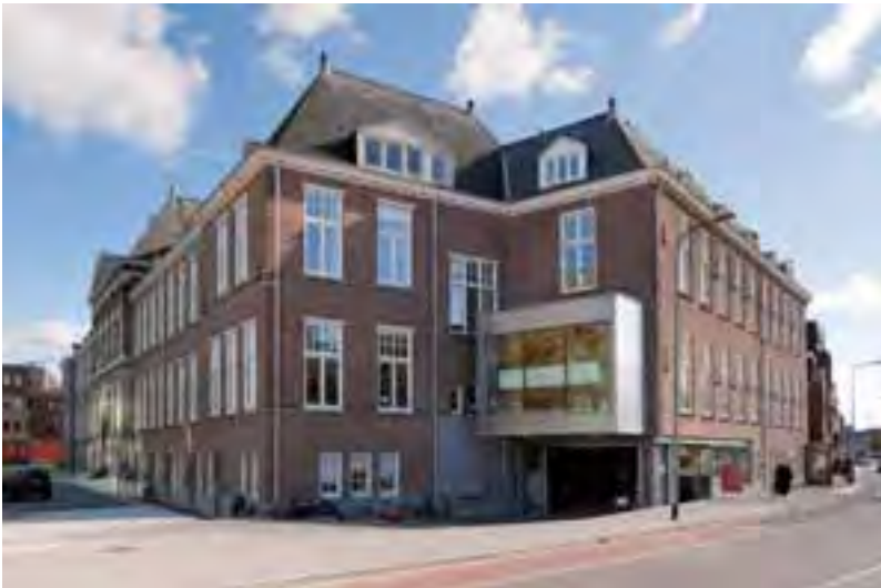
Het Paleis Groningen, cultureel woon- en werkcomplex in voormalig laboratorium
