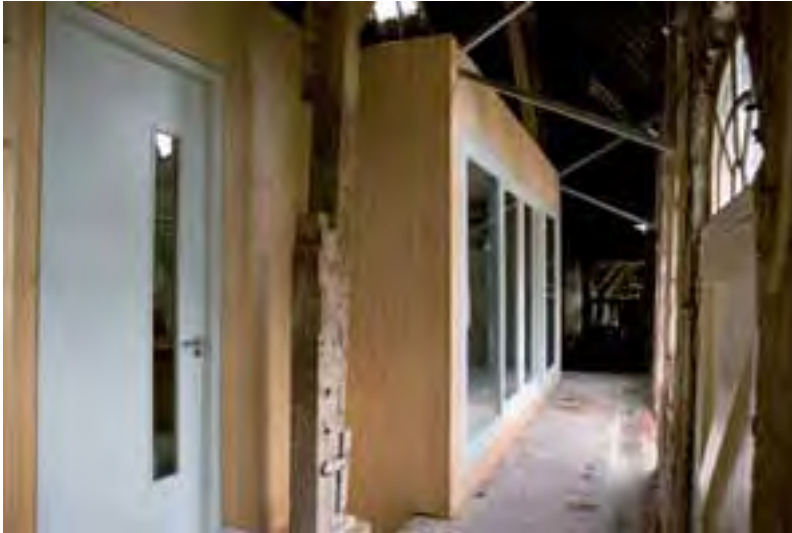
Boerderijschuur te Niehove, kantoor
