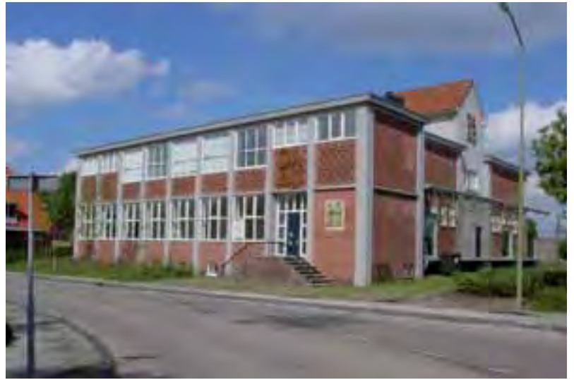
ACM gebouw Beilen, thans kantoor DAAD Architecten
