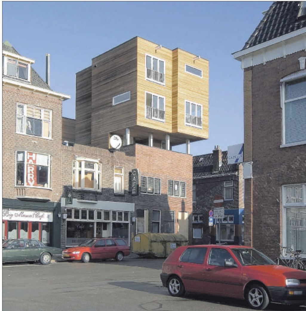
In het oog springende 'Lighthouses' aan de Raben- hauptstraat in Groningen.
