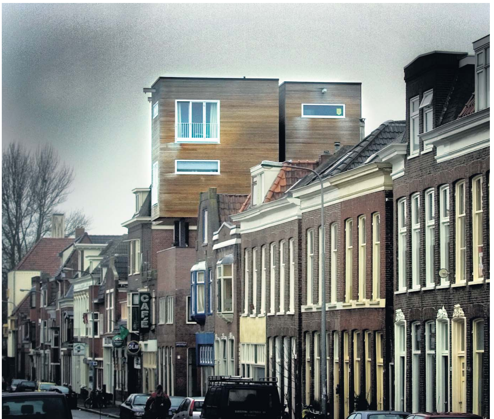
Als er op de grond geen ruimte is om te bouwen, dan moet het maar op het dak van bestaande woningen, zoals aan de Rabenhauptstraat in Groningen
