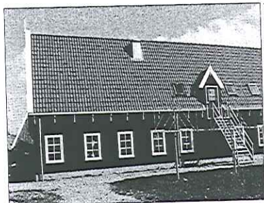
Gevelbetimmering en kozijnen van watersport- en natuurcentrum Kollumeroord in Kollum zijn van Nederlands lariks. Binnen is ook inheems populierencomplex verwerkt.
