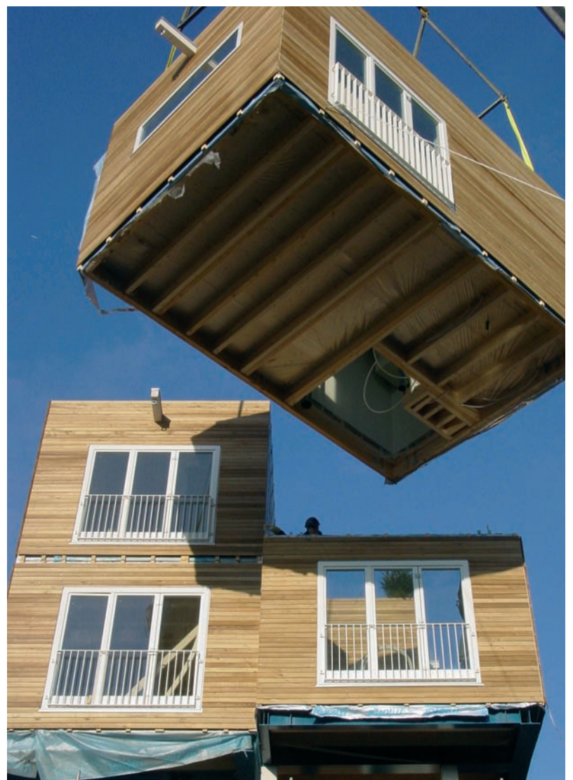
De Lighthouses worden op de plaats getakeld. Rabenhauptstraat, Groningen
