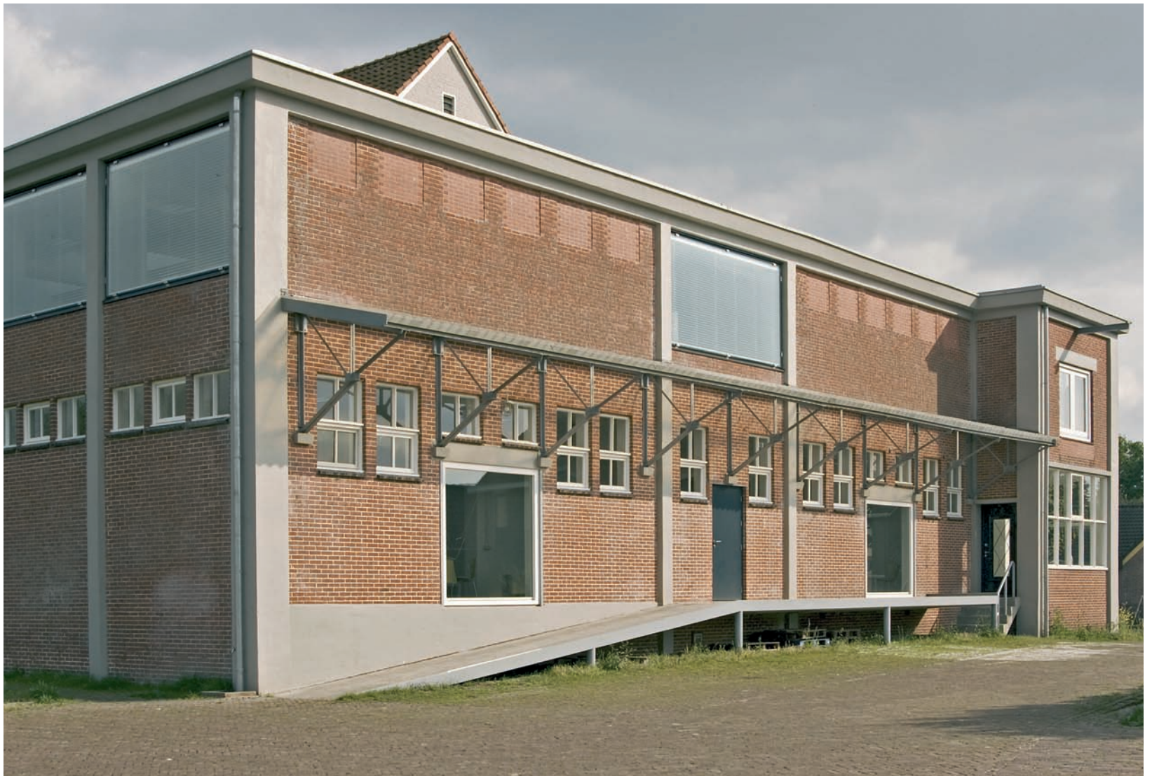
Achterzijde voormalig ACM-gebouw te Beilen.
