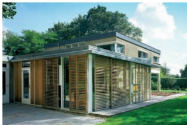
Verbouw woning te Borger.
