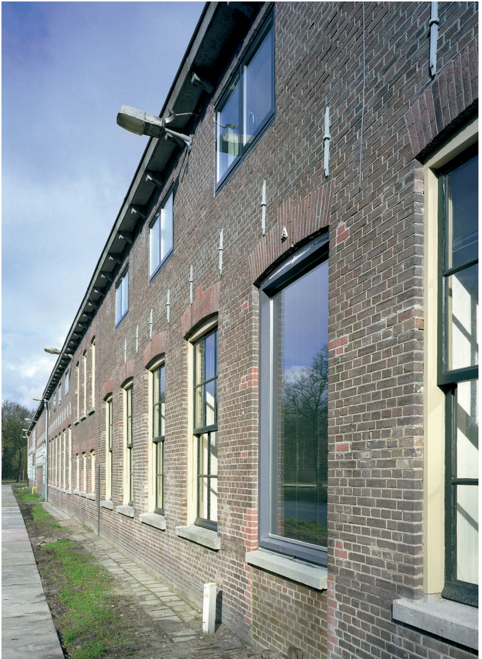
Gevelfragment voormalig werkgesticht Norgerhaven te Veenhuizen.
