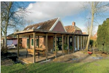
Verbouw woning te Westeremden.
