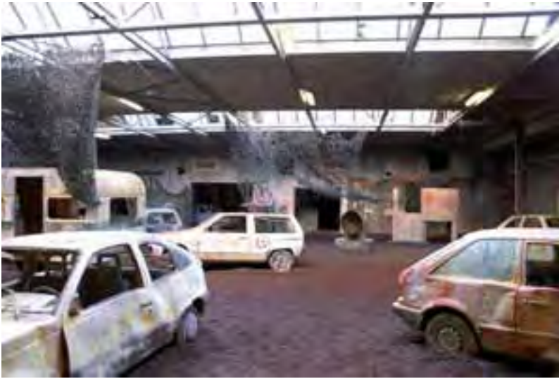
ACM complex Groningen, bestaande situatie, tijdelijk gebruik van de opslagloods
