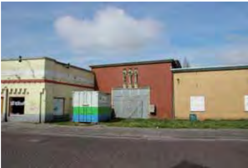
Van Heekcomplex Enschede, voormalige hoofdingang van de weverij
