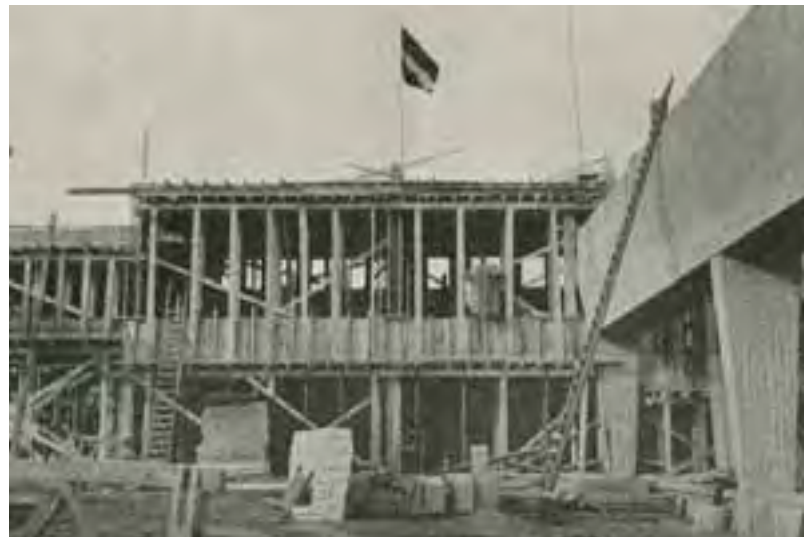
Van Heekcomplex Enschede, weverij tijdens de bouw
