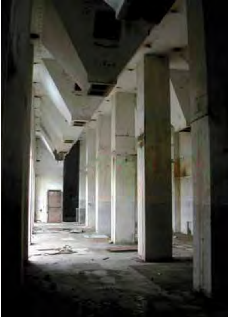
ACM complex Groningen, interieur grondstoffendoseersilo
