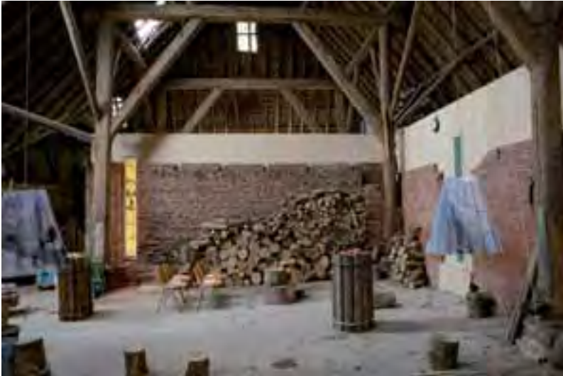
Boerderijschuur Niehove, kantoor
