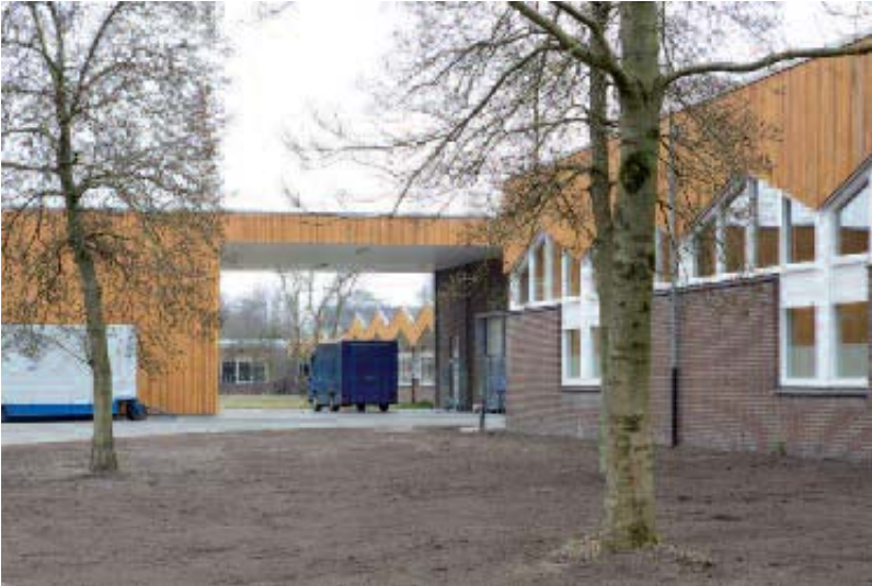
Renovatie en uitbreiding voorzieningengebouwen Nieuw Woelwijck (oorspronkelijk ontwerp Leo de Jonge)
