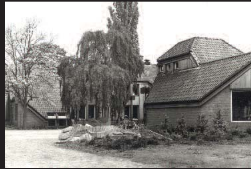
De Spinde, Dalen, 1974 (afgebroken)
