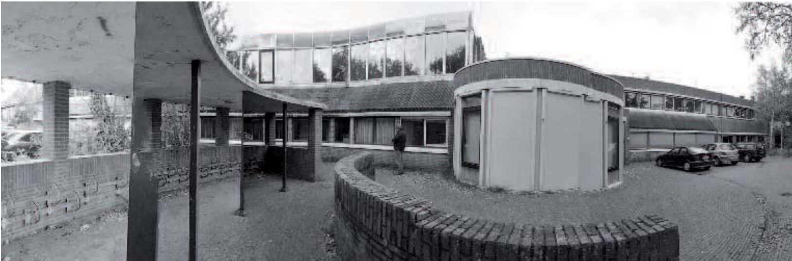
Fotomontage van het leegstaande gemeentehuis Bergen in het jaar 2010 met de kenmerkende ronde vormen, de schuin gemetselde gevels en de glazen daklichtstraten.
