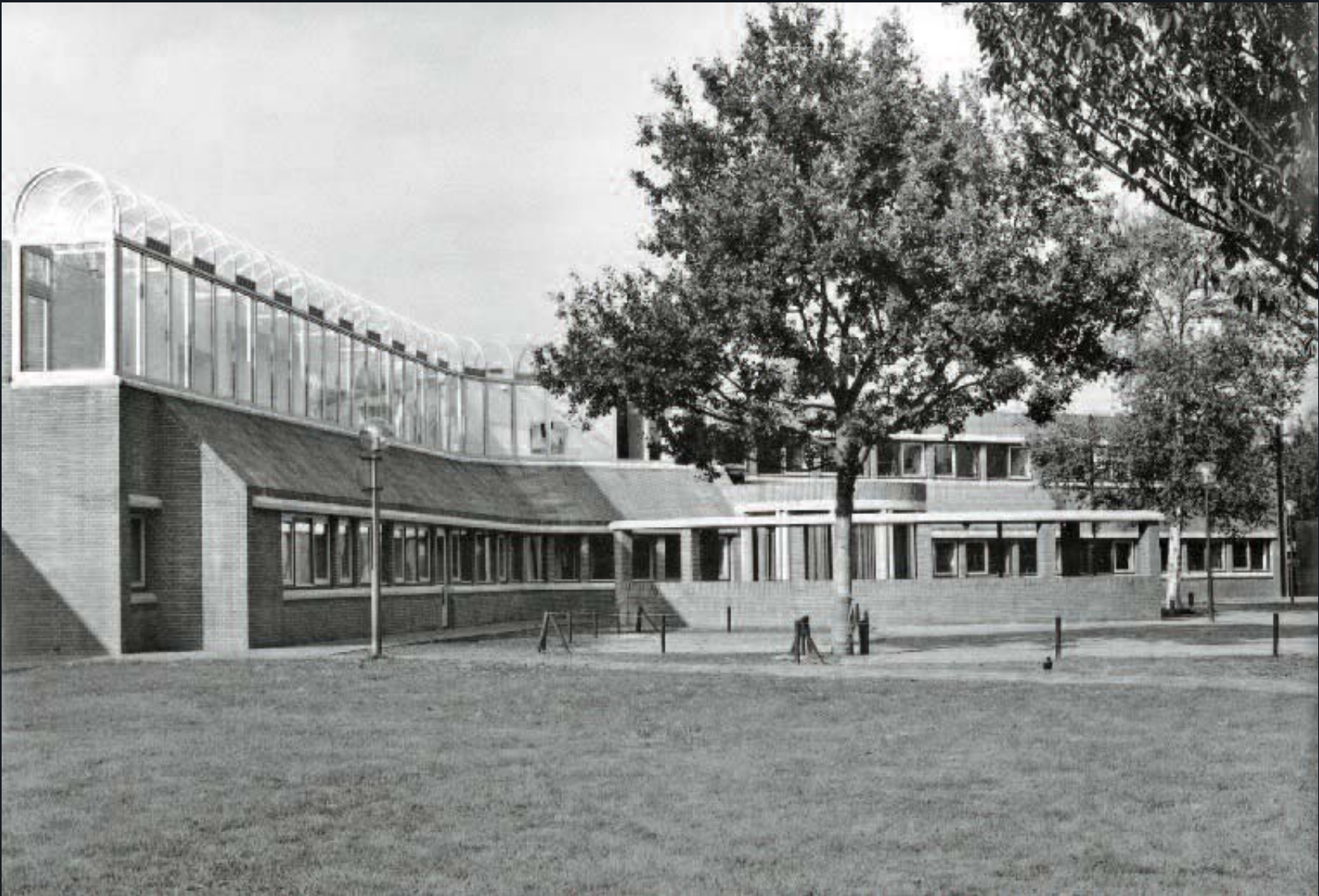
Deze opname van omstreeks 1982 geeft een goed beeld van de karakteristieken van het gemeentehuis van Bergen: gemetselde gevels, schuine vlakken en een glasstraat op de eerste bouwlaag.
