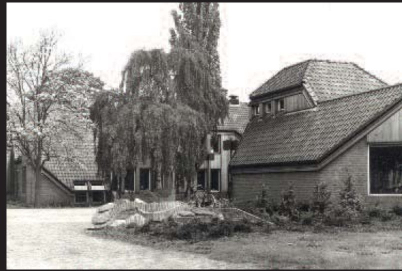
De Spinde, Dalen, 1974 (afgebroken)
