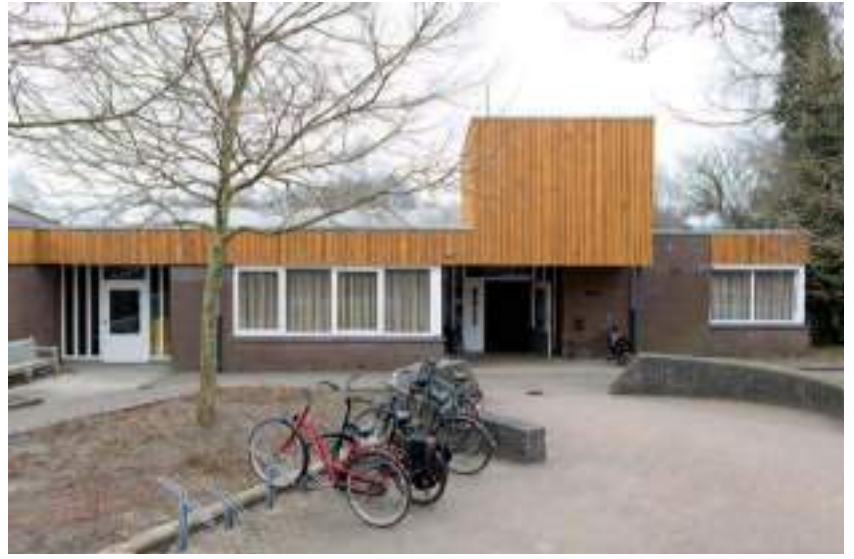
Nieuwe dakranden met een opbouw voor installaties tpv de entree.
