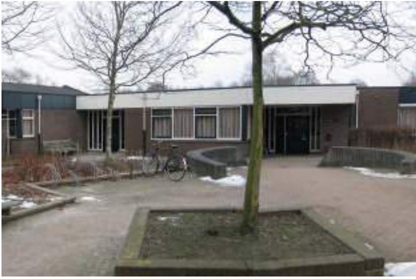
Zware dakranden drukken het gebouw, weinig accent bij de entree.
