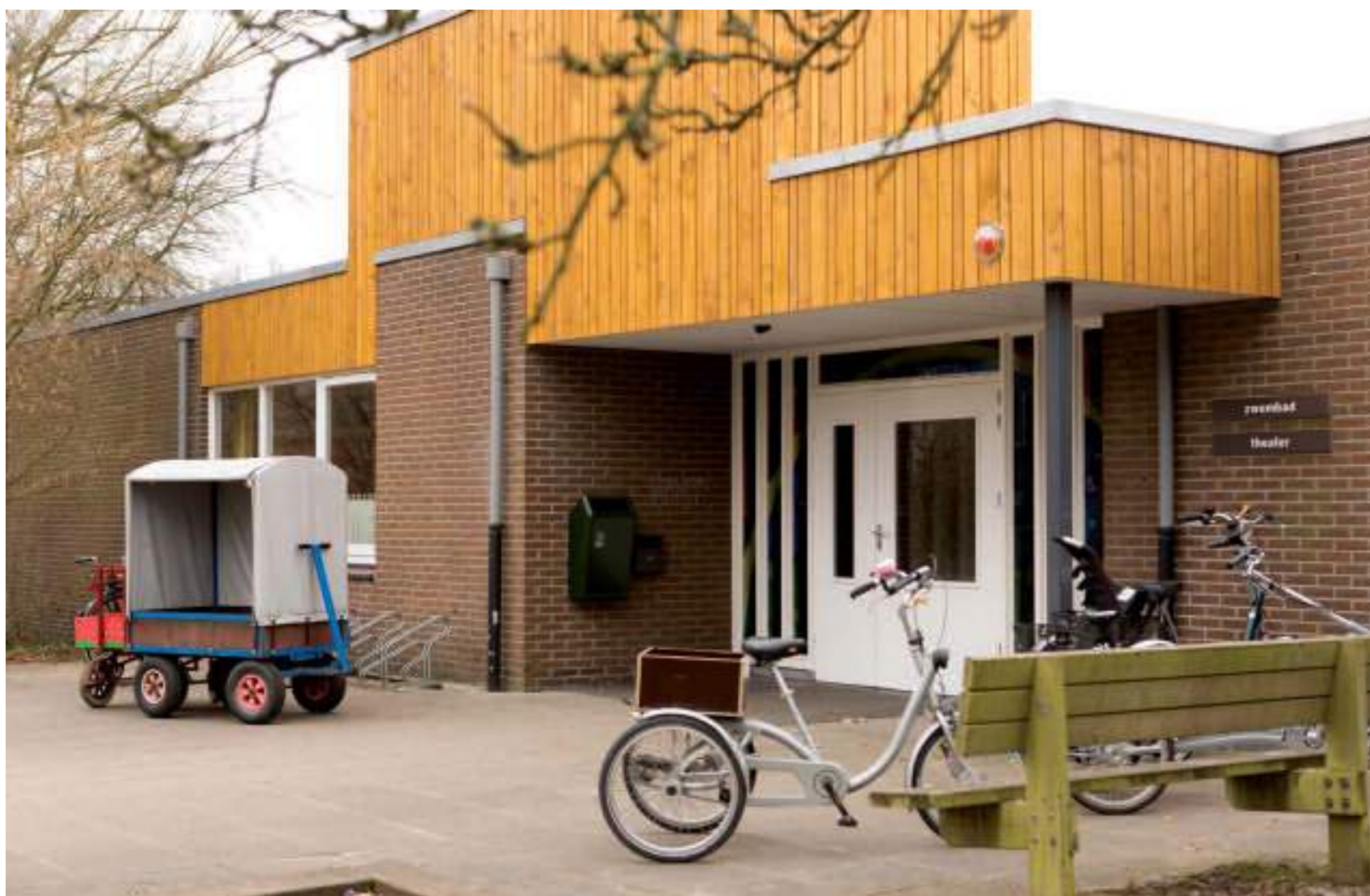
De bestaande gebouwen krijgen met de verduurzaming een vernieuwd aanzicht.
