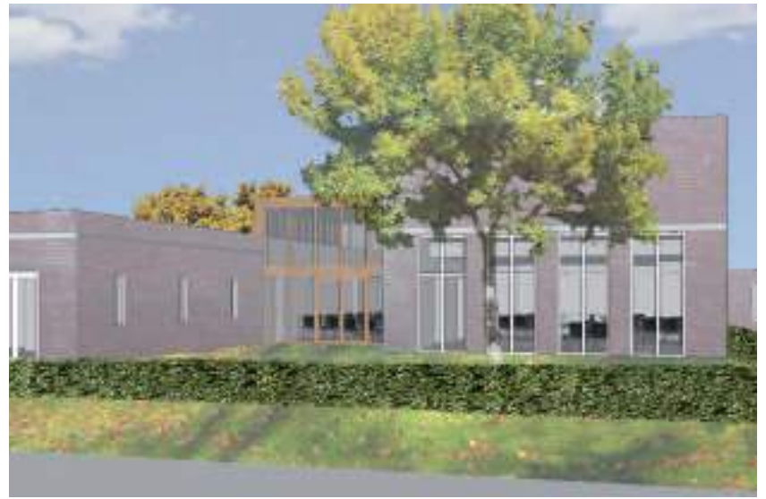
Woonzorgcentrum Selkersgoorn te Dalen.
