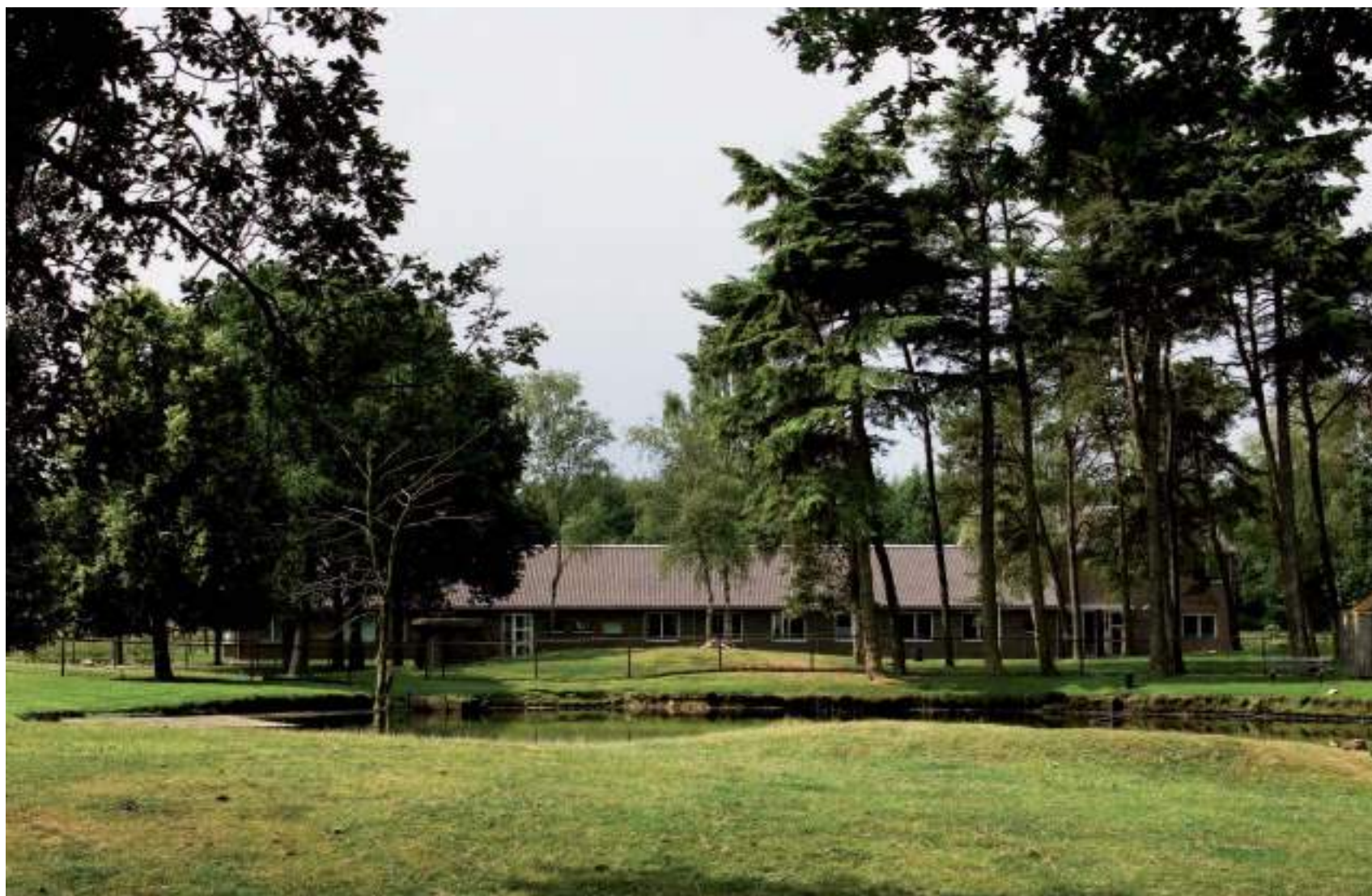
Woongebouw De Walnoot te Boschoord gezien vanuit het landschap.
