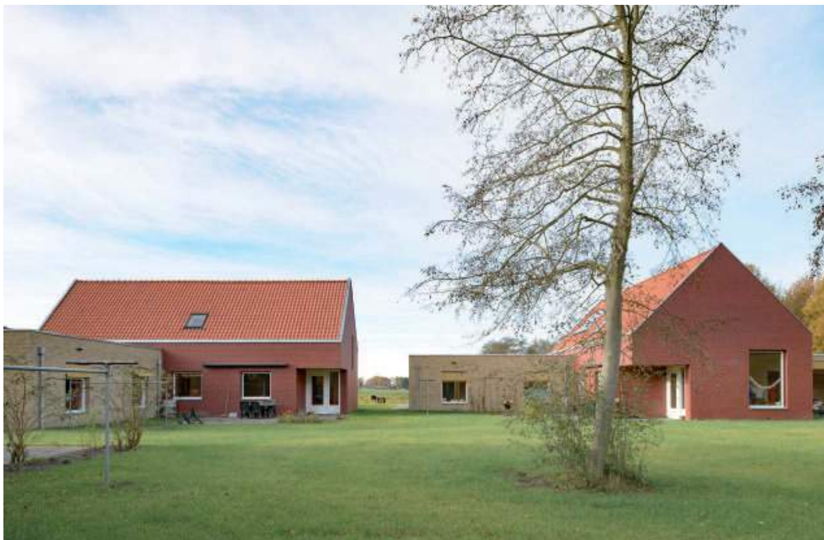
Nieuw Woelwijck; het gerenoveerde wooncluster Den.
