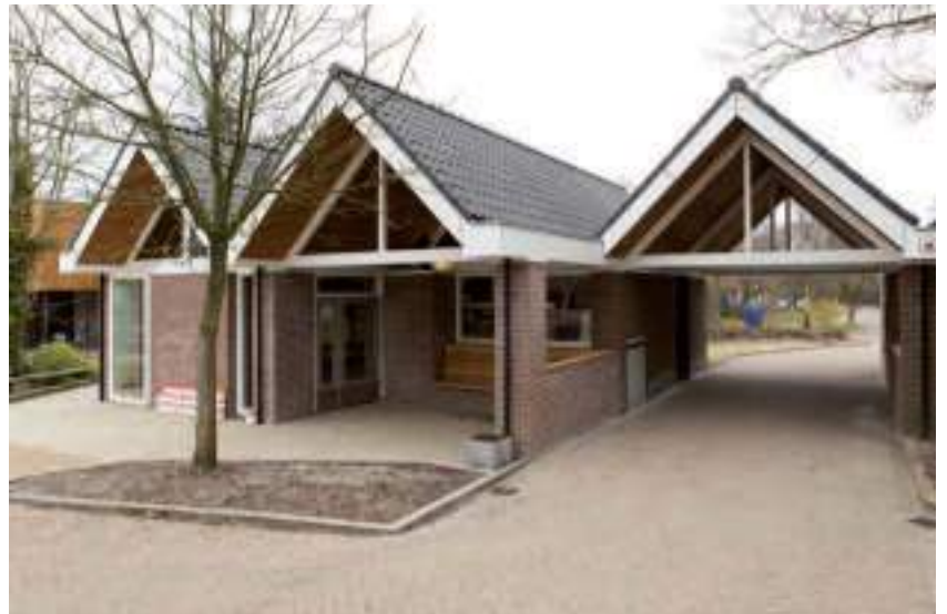
De vernieuwde kap met vergrote overstek tbv een wachtruimte voor de winkel.
