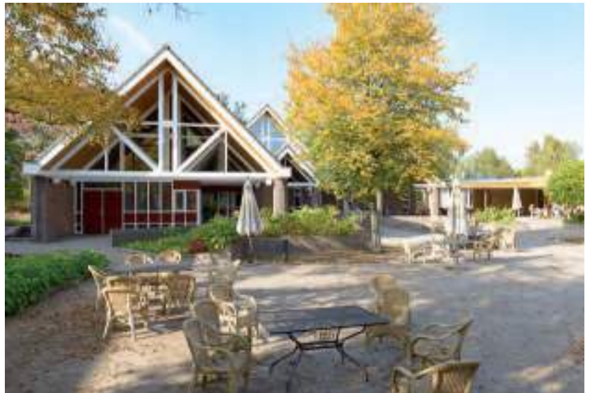
Vernieuwing van de kap met een nieuw kleurenpallet verwijst naar de oorsprong.
