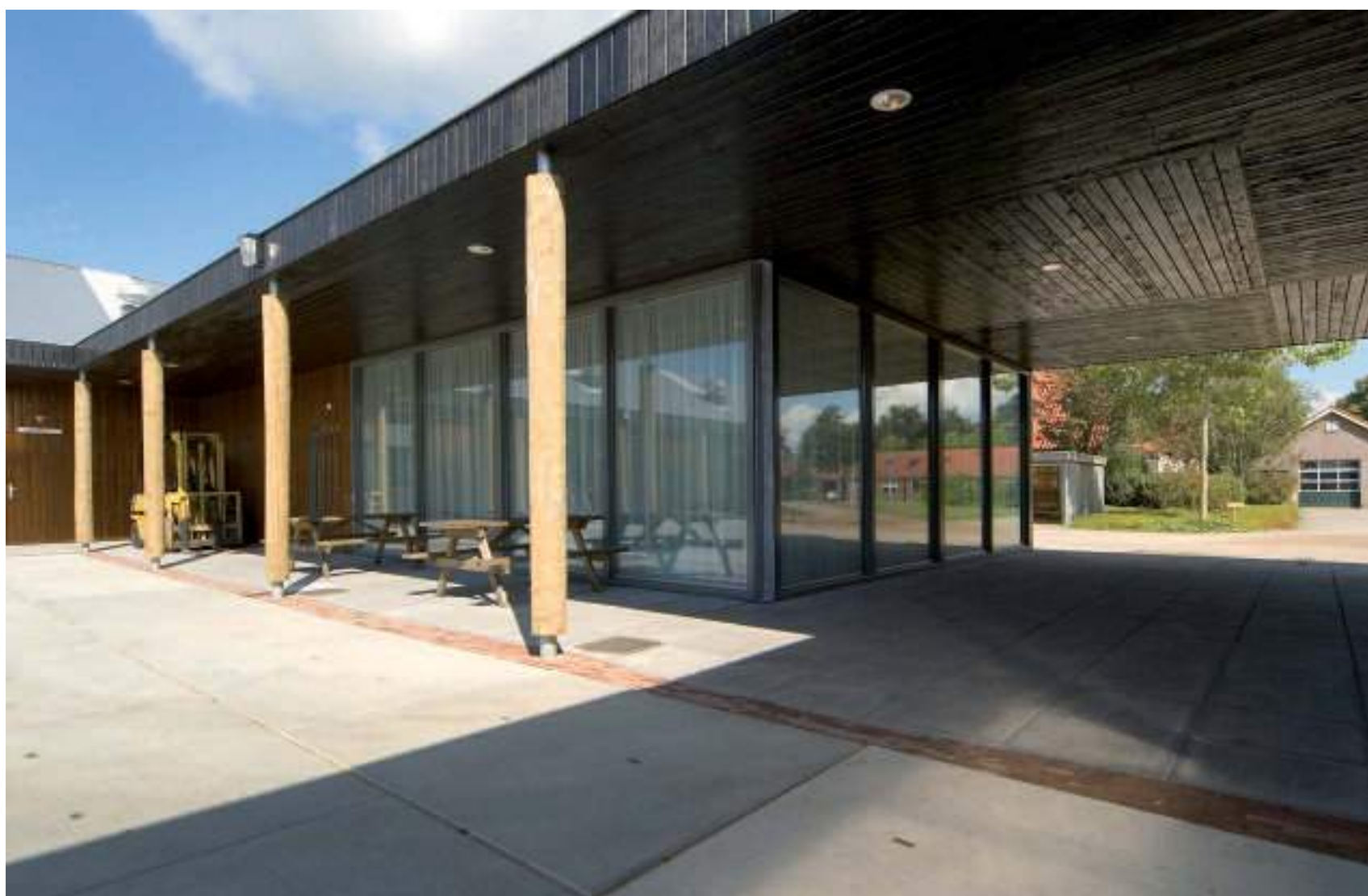
Hoeve Boschoord, werkgebouw: vanuit de afsluitbare binnenplaats – die ook als verkeersruimte functioneert – is er zicht op de omgeving.
