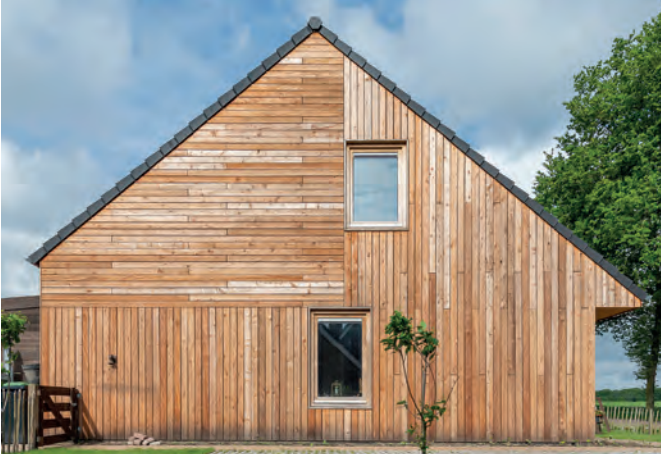
De gevelbekleding is van inlands lariks. Lokale verkrijgbaarheid was een van de uitgangspunten. 'Hout maakt ook de duurzaamheid zichtbaar.'
